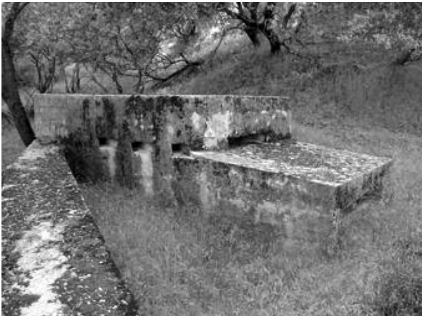
Casamata y muro anticarro en el elemento de resistencia del Perales (Quijorna)
