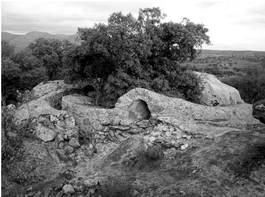
Obras blindadas en La Longuera (Fresnedillas de la Oliva)
